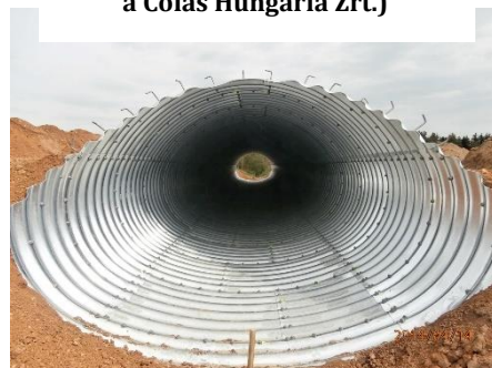
Nádasd elkerülőn 3 db hullámosított acélcső-áteresz összeszerelése (Megrendelőnk a Colas Hungária Zrt.)
