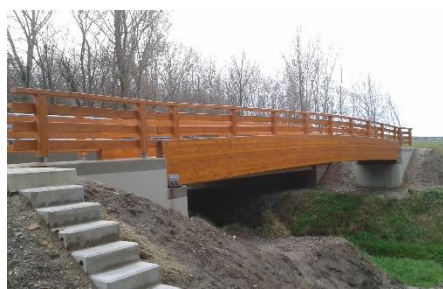
Ragasztott-rétegelt fafelszerkezetes kerékpár-úti híd építése Csömörön, a Csömör-patak felett (Megrendelőnk a Colas Út Zrt.)
