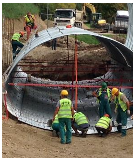
Hullámosított acélcső, és vasbeton szegélyek kivitelezése a Biatorbágyi Viadukt alatti csomópont átépítési munkálatai során (Megrendelőnk a ViaCon Hungary Kft.)
